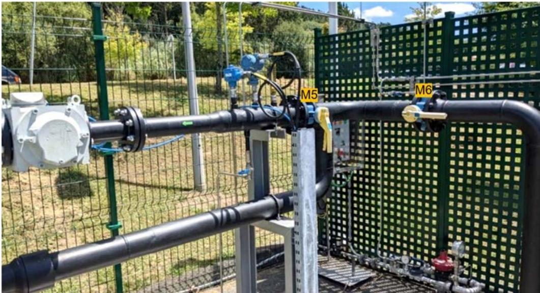
Figura 11. Válvulas de mariposa de acero en la línea de baja presión (referencias M5 y M6).
