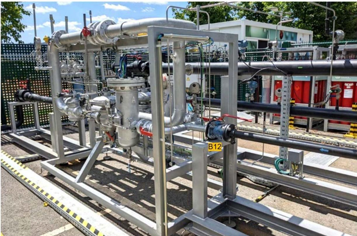
Figura 9. Válvula de bola de acero a la entrada de la ERM (referencia B12).
