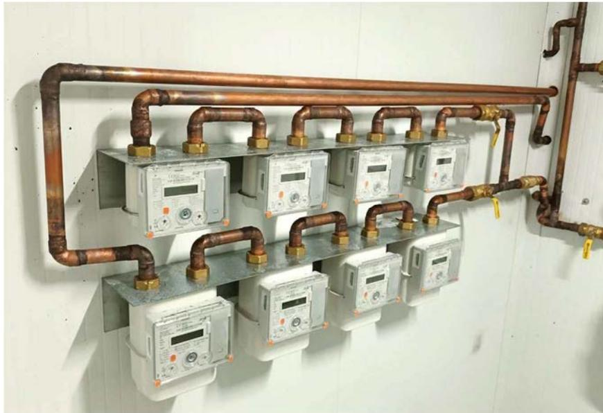
Figura 24. Línea contadores inteligentes ultrasónicos y de membrana.
