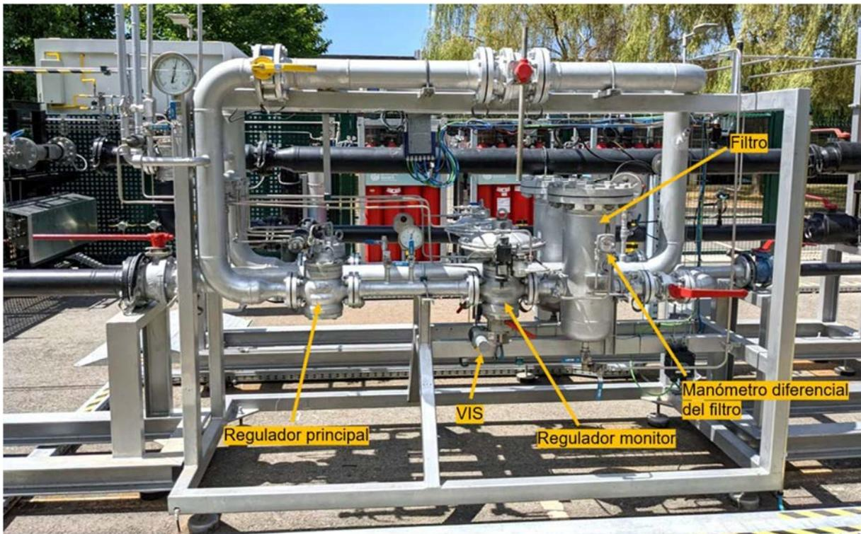
Figura 22. Componentes de la ERM.
