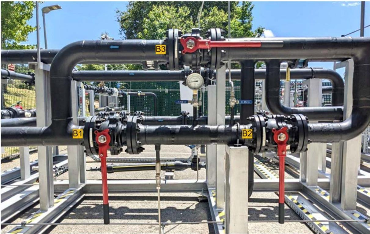
Figura 8. Válvulas de bola de acero en la línea de alta presión (referencias B1, B2 y B3).
