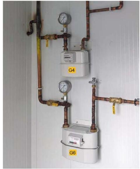
Figura 15. Armario de regulación de vivienda (izq.) y contadores (dcha.).
