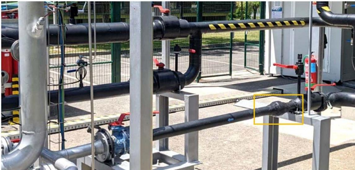
Figura 10. Junta dieléctrica a la entrada de la ERM (línea 16 bar).
