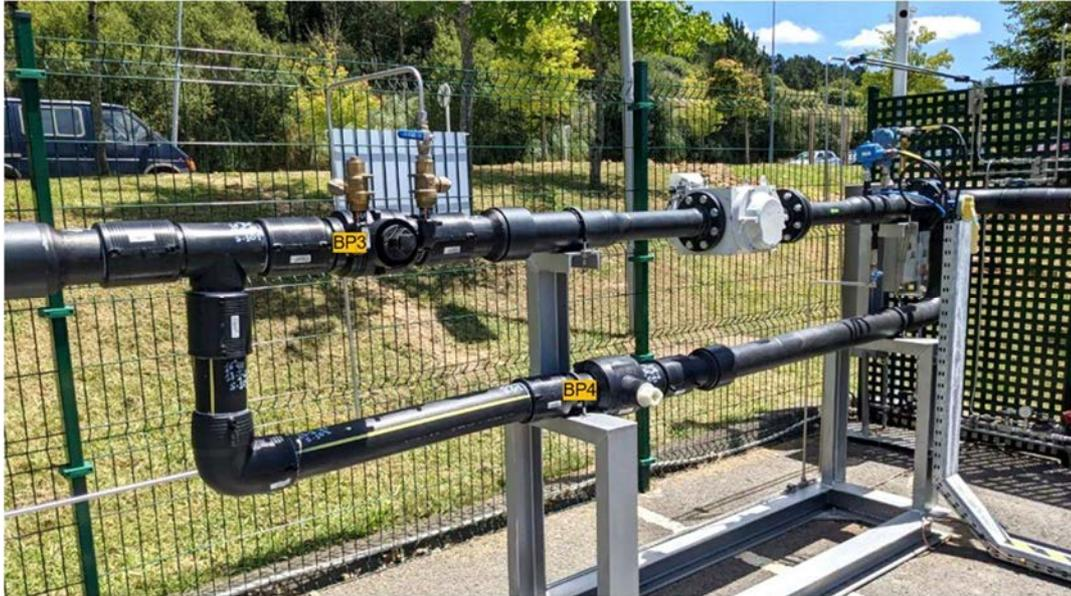
Figura 13. Válvula de bola de polietileno en la línea de baja presión (referencias BP3 y BP4).
