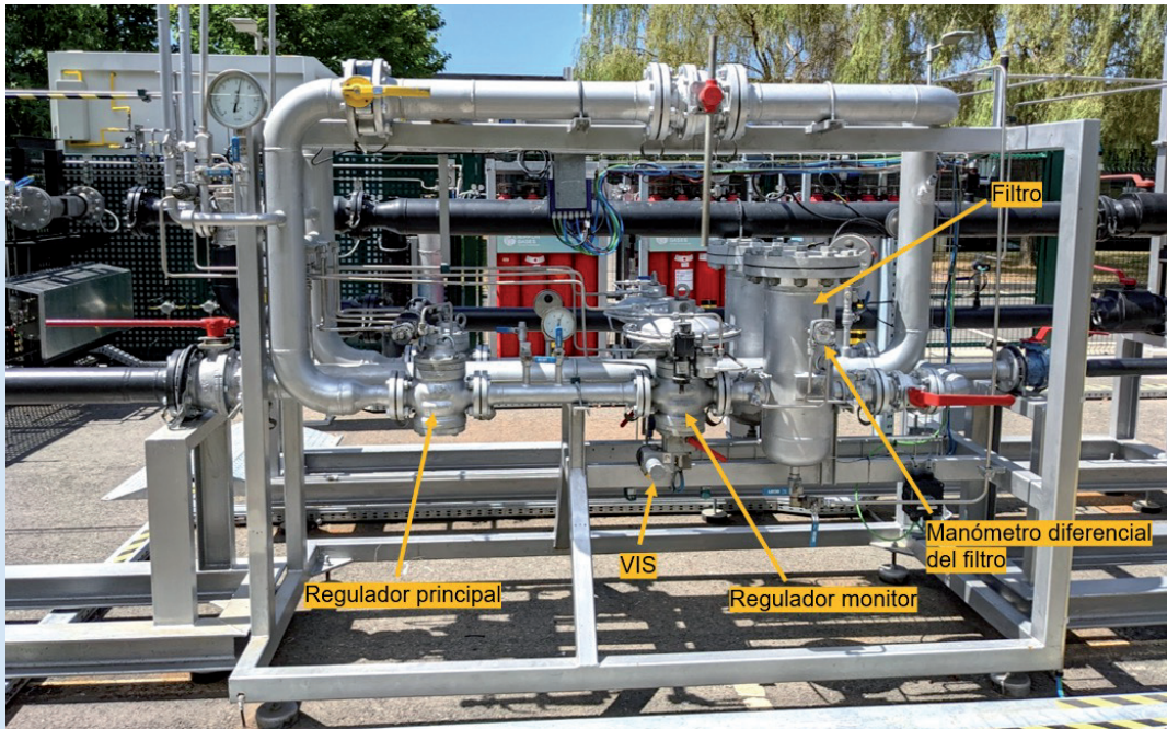
Figura 17 - Componentes de la ERM
