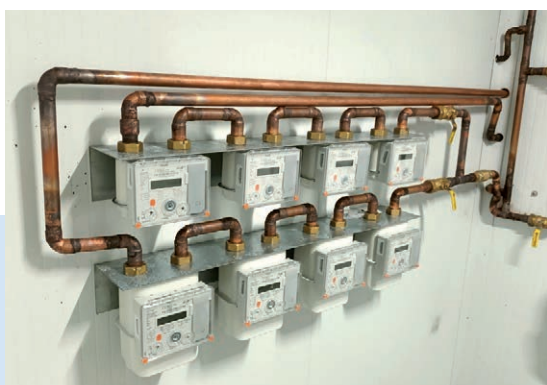
Figura 18 - Línea contadores inteligentes ultrasónicos (arriba) y de membrana (abajo)
